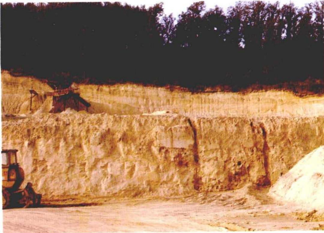
FOTO 4.3.4.4. El sistema de explotación C7, ocasiona paredes casi verticales y lisas de difícil integración en el paisaje circundante.
