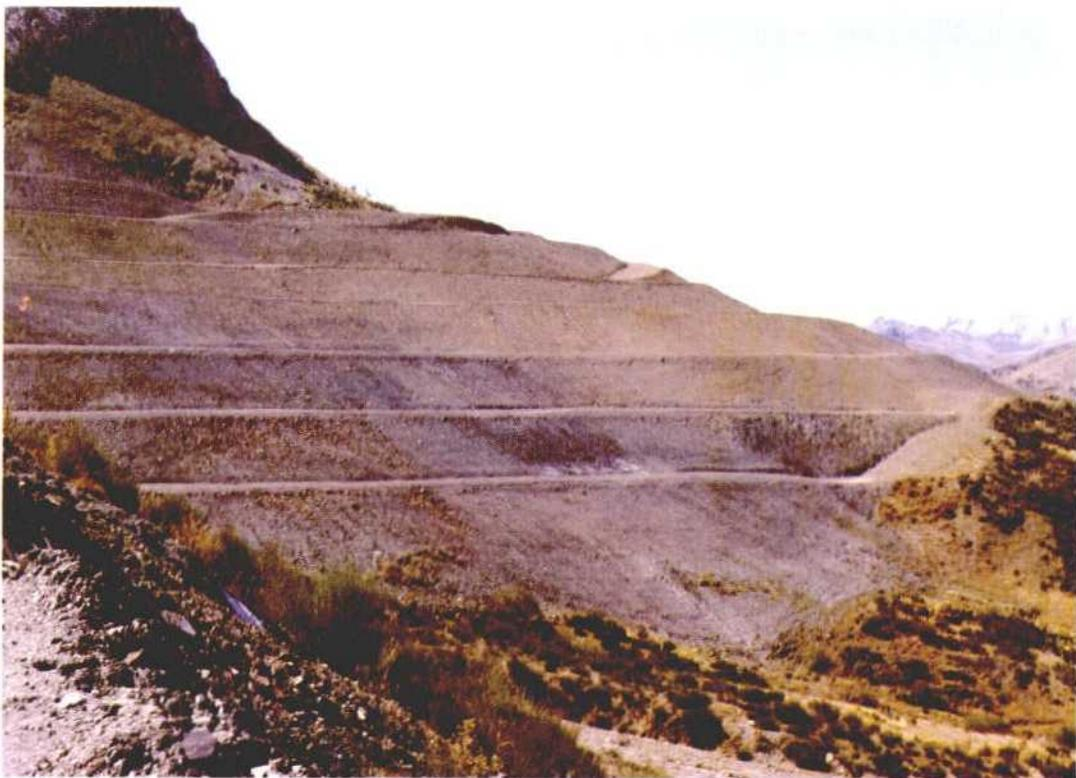
FOTO 5.1.1.2. La disposición geométrica y la uniformidad de bermas produce un impacto visual.
