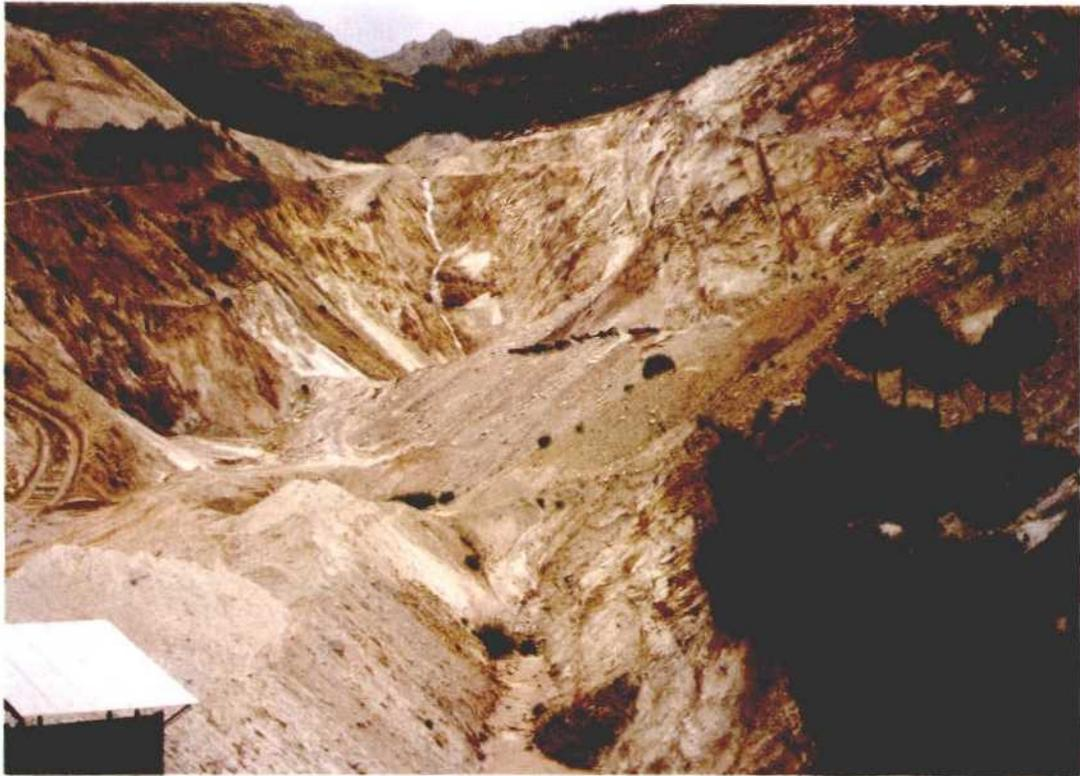
FOTO 5.1.2.1. La apertura de la corta puede ocasionar alteraciones sobre la red de drenaje superficial.
